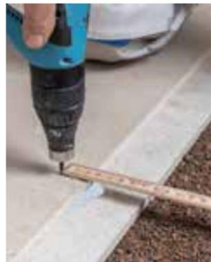
*Posizionamento sul lato superiore della battuta dell'elemento per pavimento Rigidur® da fissare*
