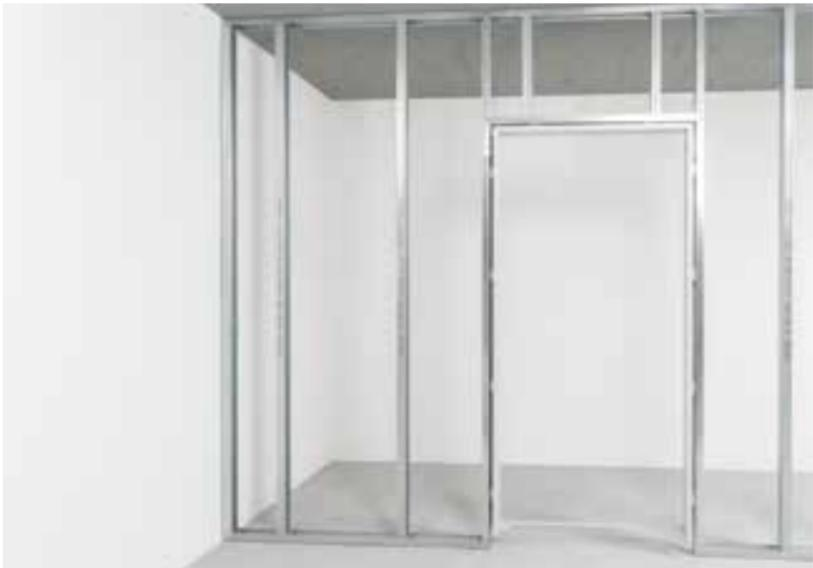
Sottostruttura appositamente predisposta
