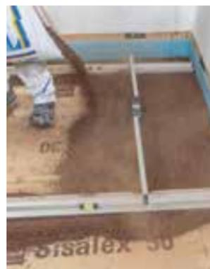
*Applicazione e spianamento del sottofondo livellante Rigidur®*
