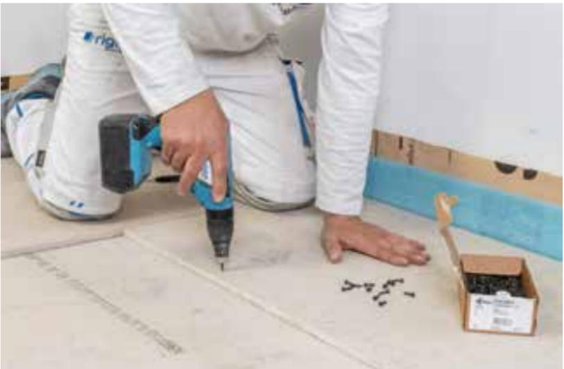
*Fissaggio dello strato supplementare dopo l'incollaggio*
