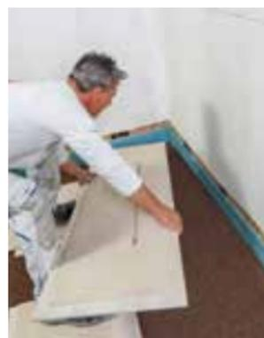
*Posa degli elementi per pavimento Rigidur® su sottofondo livellante Rigidur® mediante apposite «isole»*
