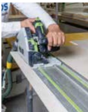
*Smarginamento della battuta di elementi per pavimento Rigidur® in corrispondenza del raccordo con la parete*
