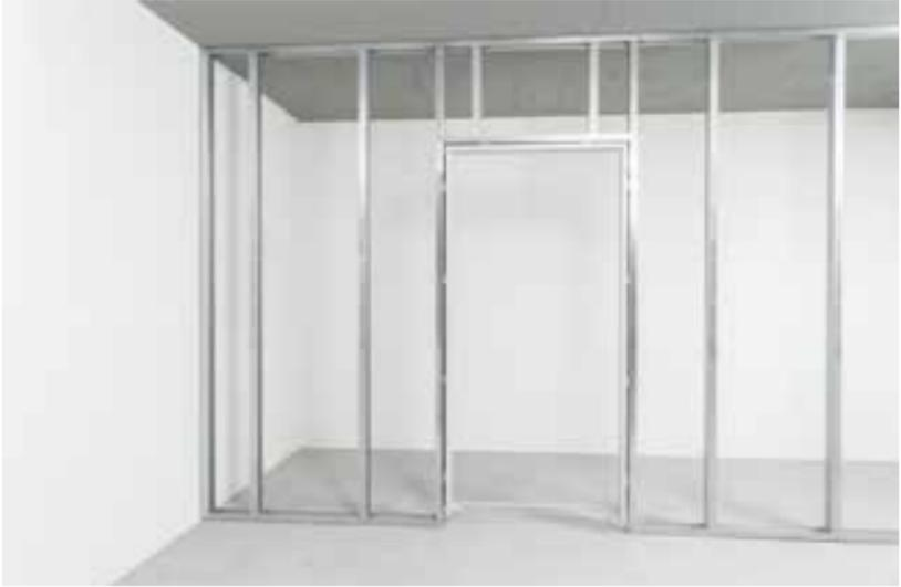
*Sottostruttura appositamente predisposta*
