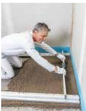
*Spianamento e lisciatura dello strato di sottofondo livellante Rigidur® legato 2:1*
