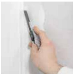
**!** Nelle pareti con sottostruttura metallica senza elementi a incasso i bordi di taglio delle lastre da costruzione Rigips® possono essere smussati con il pialletto per bordi Vario Rigips® e, successivamente, stuccati con malta per giunti Vario Rigips® senza dover ricorrere a un nastro di armatura. Questo tipo di lavorazione è descritto nelle Direttive di lavorazione - Parte 4, Capitolo 4.3.
