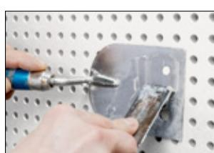
Die Trocknungszeit des Fugensystems optimal nutzen, um die Schraubenköpfe in den Plattenmitten auch mit dem jeweiligen Spachtelmaterial und mithilfe einer Rigips® Schraubenkopfspachtel (Art. 21909) zu verspachteln.
