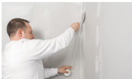
Eliminare infine il lembo di striscia di separazione Rigips® Fix rimasto in evidenza tagliandolo a filo.
