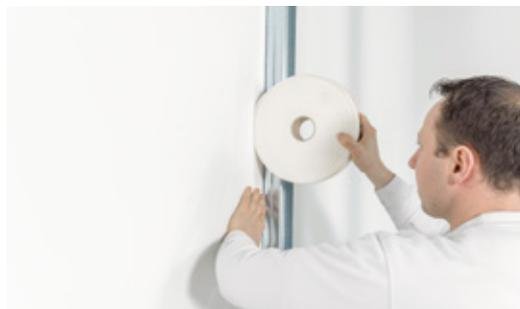
Montare le lastre in cartongesso Rigips® portandole bene in battuta contro la striscia di separazione (se lo spessore del giunto è maggiore di 2 mm è necessario sigillarlo con uno stucco di sistema).
