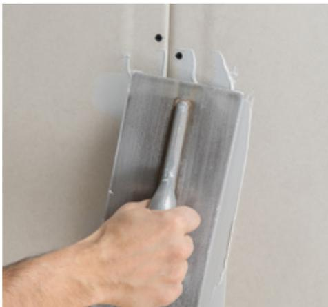
Riempire i giunti longitudinali con lo stucco di sistema Rigips® Promix applicandolo in senso trasversale al bordo assottigliato della lastra e premendolo bene all'interno della fessura.
