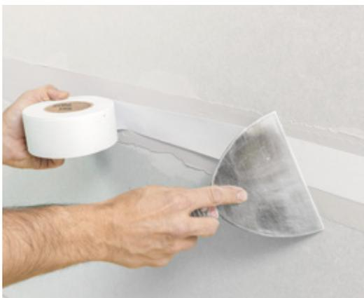
*Applicare ora con precauzione il nastro di armatura Rigips® in carta.*
