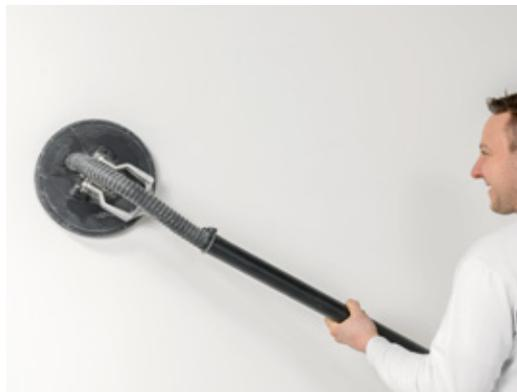
*Che sia o meno necessario provvedere a una levigatura finale dello stucco completamente asciutto (a mano o a macchina) dipende dalla classe di qualità convenuta per contratto, ovvero dalla qualità di superficie prestabilita.*
