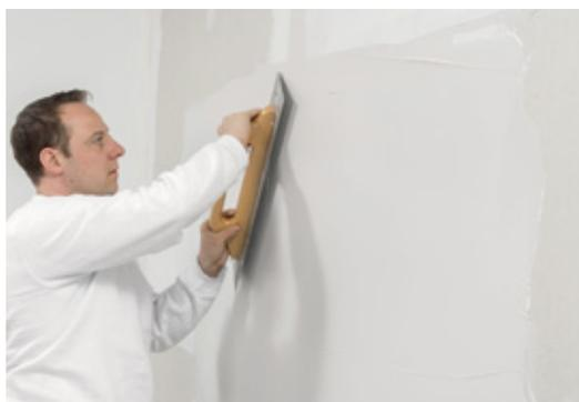
*A stucco ancora fresco rasare la superficie con un frattazzo lungo e lasciar asciugare completamente.*
