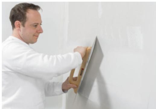
*Lo stucco di sistema Rigips® ProMix Spray Joint si può tirare «a zero» senza problemi. Già nel far ciò si potrà constatare l'eccellente qualità della superficie.*
