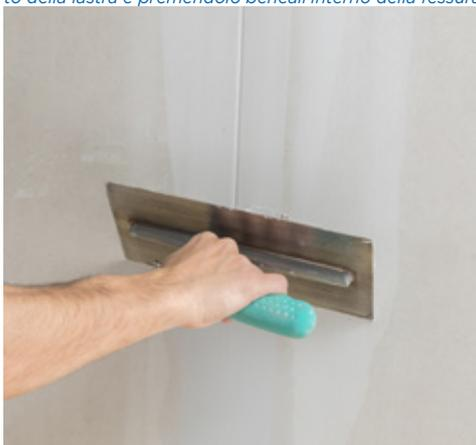
A essiccazione completa stendere uno strato di stucco spesso ca. 1 mm..
