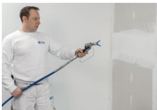
*Applicare uniformemente lo stucco sull'intera superficie della parete avendo cura di spruzzarlo con movimenti regolari. Per ottenere la classe di qualità 4 (Q4) è necessaria una seconda mano.*
