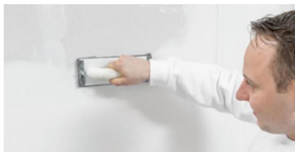
*Controllare visivamente la qualità della stuccatura preliminare (sigillatura) e rimuovere eventuali bavature di stucco rimaste in evidenza.*
