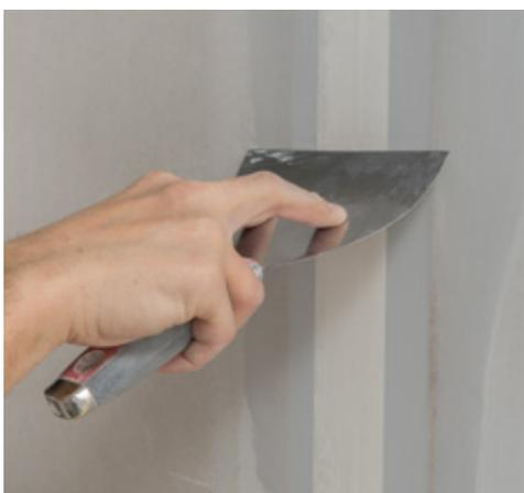
Premere il nastro di armatura Rigips® in carta nel letto di stucco avendo cura di evitare che si formino bolle d'aria.
