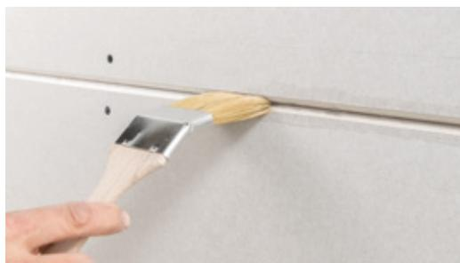
*Inumidire i bordi di testa o trattarli con il fissativo antipolvere Rigips® Rikombi neutral affinché non venga sottratta, troppo rapidamente, acqua alla malta per giunti di sistema Rigips® e la stessa si essicchi troppo velocemente.*
