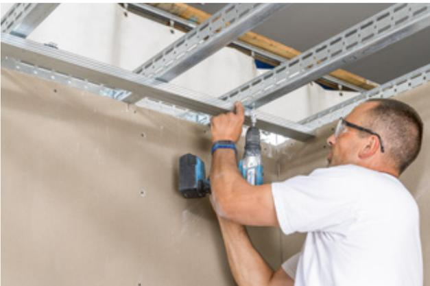
*Copertura RiBox® in profili per grandi campate predisposta per il montaggio della sottostruttura a telaio semplice*
