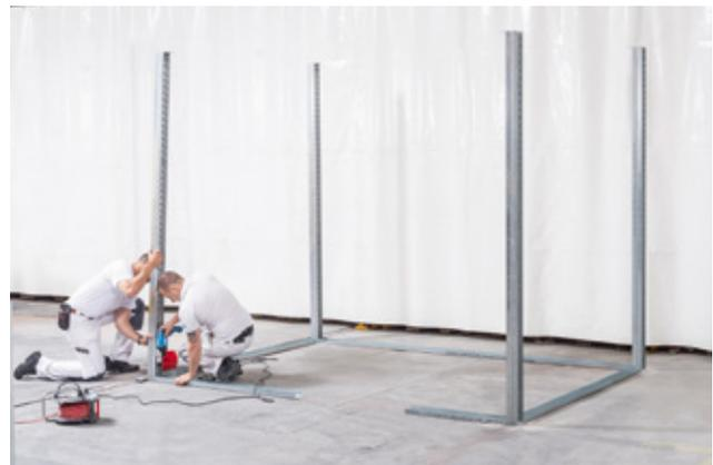
*Montaggio e fissaggio dei quattro pilastrini di base*
