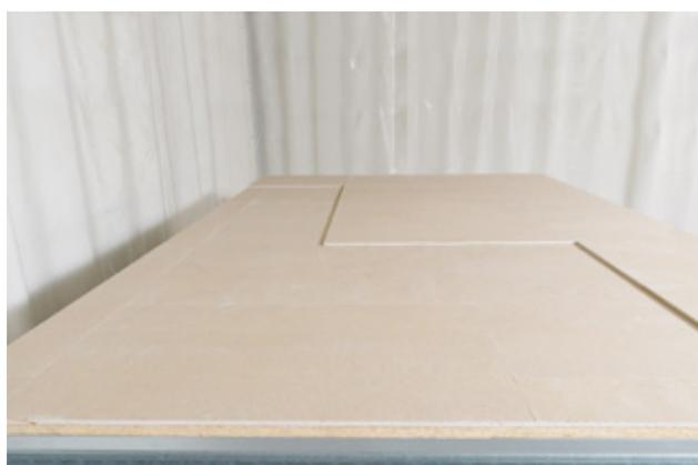
*Sfalsamento dei due strati di rivestimento in lastre Rigidur® H*
