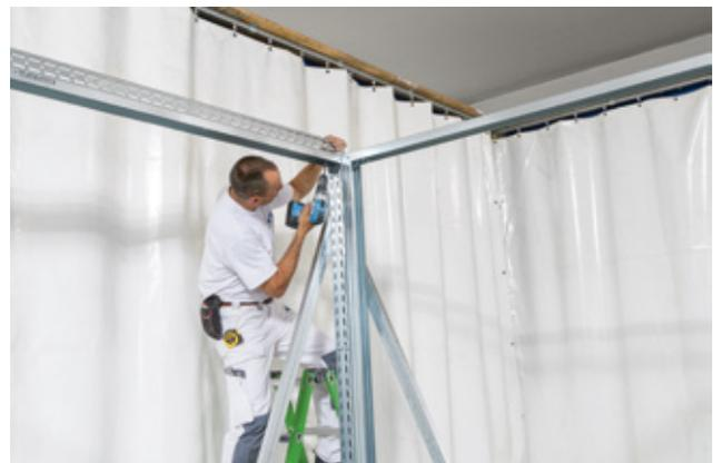
*Posa e fissaggio a vite del profilo che funge da trave orizzontale*
