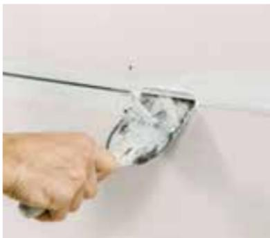
Les joints sont comblés avec la masse à jointoyer Rigips® Vario. Veiller à ce que l'adhérence avec les bords des plaques soit suffisante.
