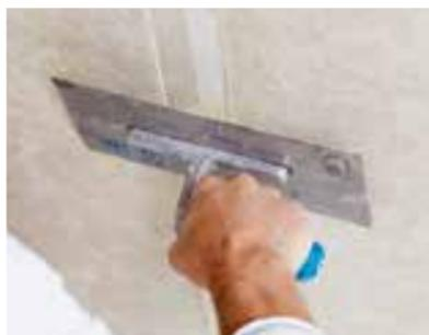
Les plaques Rigidur® H sont bien aboutées les unes aux autres au niveau des bords aplatis. Appliquer la masse à jointoyer Rigips® Vario et la spatuler à fleur de surface.
