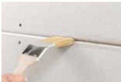
Humidifier les bords transversaux ou les apprêter avec la barrière neutre Rigips® Rikombi pour que l'eau ne se retire pas trop rapidement du système de masse à jointoyer Rigips®, qui sécherait alors trop rapidement.
