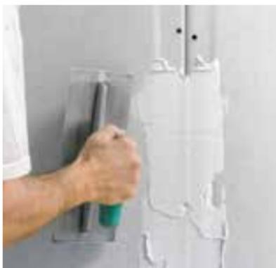
Comblers les joints longitudinaux perpendiculairement au bord Vario avec la masse à jointoyer Rigips® Vario.
