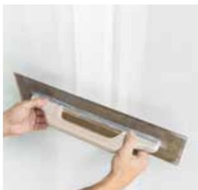
Appliquer la masse à jointoyer à la surface des plaques, et tirer l'excédent jusqu'à l'épuiser vers l'extérieur du joint.
