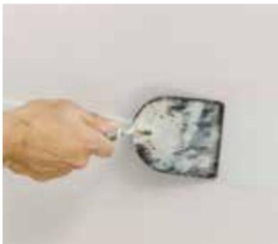
Appliquer un lit d'enduit de 1 mm d'épaisseur environ avec la masse à jointoyer Rigips® Vario.
