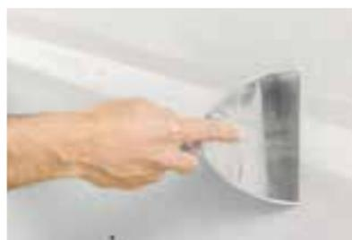
La pose de la bande d'armature papier Rigips® se fait avec application supplémentaire de produit.
