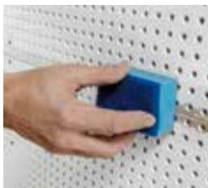
Fixer le ruban Primeline Strip avec le côté brillant au milieu du joint de plaque humidifié et presser avec le pouce jusqu'à ce que les deux côtés du ruban Primeline Strip soient entièrement en contact avec la plaque perforée.
