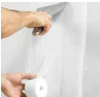
La pose de la bande d'armature en fibres de verre Rigips® se fait juste après, dans le frais.
