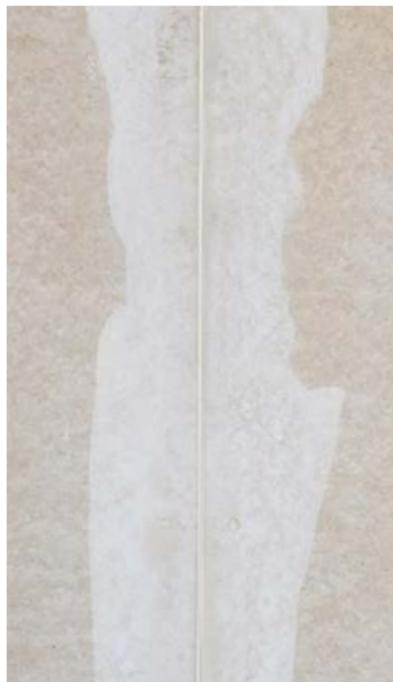
Le joint avec Rigidur® bords SK selon la technique de spatulage des joints, avec interstice de 5 mm pour le joint et mise en œuvre avec la masse à jointoyer Rigips® Vario.
