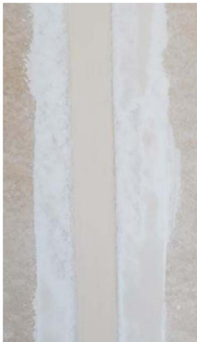
Joint avec Rigidur® AK bande d'armature Rigips® et masse à jointoyer Rigips® Vario.
