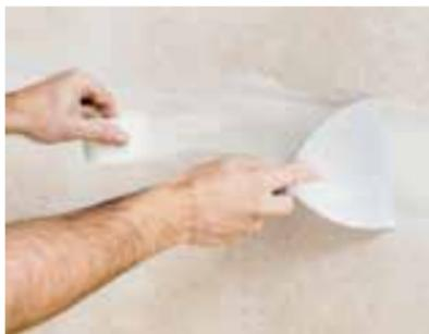
Enrober la bande d'armature Rigips® sans jointoiment ultérieur immédiat. Recouvrir les fixations de masse à jointoyer.
