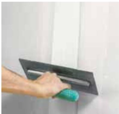
Le traitement ultérieur avec la masse à jointoyer Rigips® Vario peut être appliqué une fois que le produit utilisé pour le remplissage des joints a pris.
