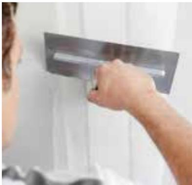
Il faut veiller à éviter la formation de bulles d'air dans les joints lors du remplissage.
