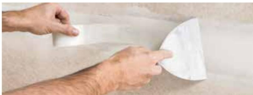
Pour l'armature des joints, on peut utiliser la bande d'armature Rigips®. La spatuler sans application supplémentaire de produit.
