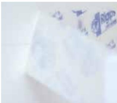
Coller la bande de joint spéciale Rigips® Glasroc X sur tous les joints longitudinaux et transversaux, ainsi que sur tous les angles sortants et rentrants.
