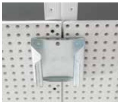
Le montage des plaques est terminé, et les plaques sont alignées à l'aide de gabarits adaptés au type de perforation concerné. Après contrôle optique, elles sont vissées sur les rangées de perforation (rectiligne et diagonale).
