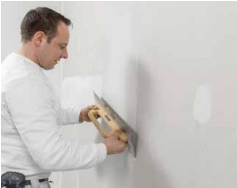
Pour la finition, appliquer un enduit de lissage sur le support.
