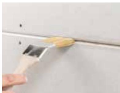
Humidifier les bords transversaux ou les apprêter avec la barrière neutre Rigips® Rikombi pour que l'eau ne se retire pas trop rapidement du système de masse à jointoyer Rigips®, qui sécherait alors trop rapidement.
