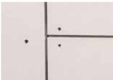
Après la pose, l'écart entre les plaques est d'environ 5 mm.
