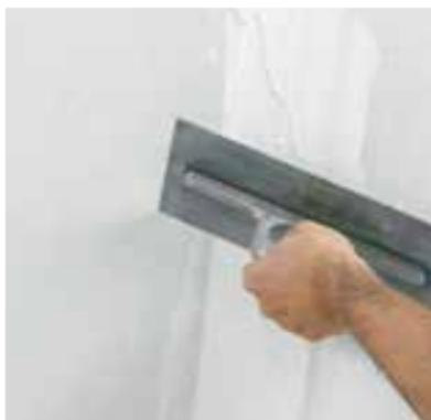
Comblent les joints longitudinaux perpendiculairement au bord aplati avec le système de masse à jointoyer Rigips® et les spatuler rapidement.
