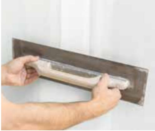
Après la finition des joints, lorsqu'ils sont complètement plats, la surface est prête pour l'étape suivante.
