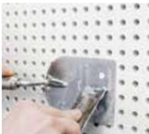
Une fois que le spatulage des têtes de vis a séché, passer délicatement la grille à poncer le long des joints pour égaliser légèrement la structure laissée par le passage du rouleau en laine d'agneau. Éviter les mouvements de va-et-vient.
