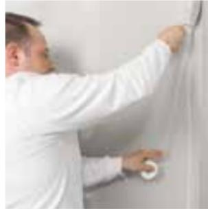
Si un bout de bande d'étanchéité Rigips® Fix dépasse, il faut le couper à fleur de surface.
