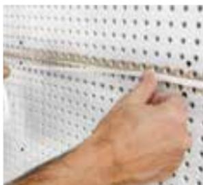
Tremper le rouleau en laine d'agneau dans la colle liquide et puis repasser l'éponge sur le strip de haut en bas. Recouvrir généreusement de colle liquide la zone des joints préalablement garnie du ruban Primeline Strip. Ne pas exercer une pression trop forte sur le rouleau en laine d'agneau. La structure laissée par le passage du rouleau doit être bien visible.
