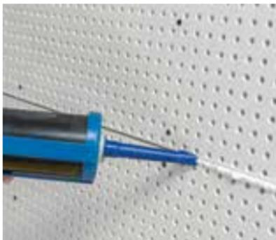
Remplir complètement les joints. Un renflement doit se former sur la plaque.
