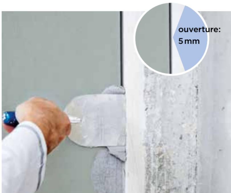
Tous les raccords aux parties d'ouvrages attenantes doivent être exécutés avec un écart de 5mm entre les plaques. Les joints doivent être remplis avec la masse à jointoyer Rigips® Aquaroc ProMix Finish. Une fois que la masse à jointoyer a durci, le surplus de bande d'étanchéité est détaché à fleur de surface.
