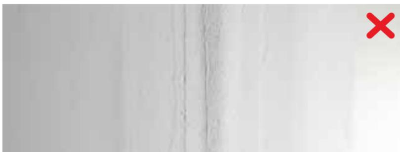
**!** Si la bande d'armature en fibres de verre Rigips® est recouverte d'une nouvelle couche de masse à jointoyer immédiatement après la pose, cela provoque un effet de «boudage»: au milieu du joint, la bande d'armature en fibres de verre tombe vers l'extérieur et se décolle vers l'avant.
