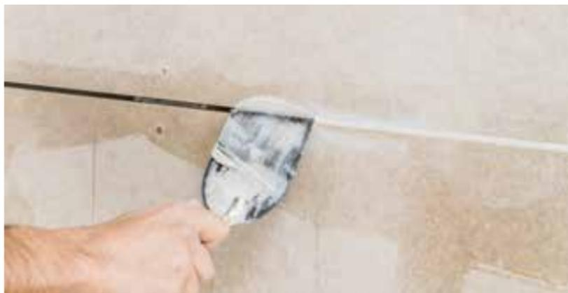
Remplir le joint avec la masse à jointoyer Rigips® Vario. Ensuite, laisser sécher
