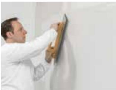
Avec un enduit de surface, spatuler et lisser la masse à jointoyer fraîchement appliquée. Il faut la laisser complètement sécher.
