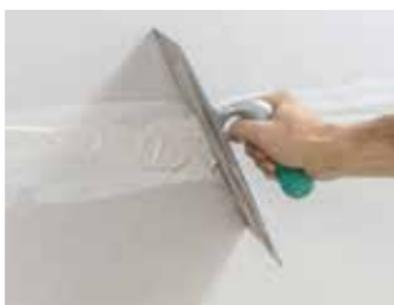
Les joints transversaux sont comblés avec la masse à jointoyer Rigips®.
