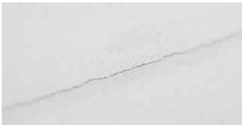
*Des fissures discontinues apparaissent souvent dans le joint suite aux processus décrits ci-dessus.*
