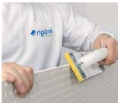
Raboter légèrement les bords des plaques Rigiton® Ambiance au moyen d'une ponceuse à main, puis les apprêter avec la barrière neutre Rigips® Rikombi sur tous les faces.
