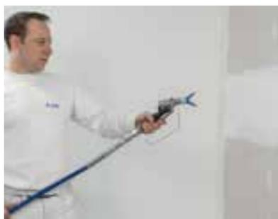
Appliquer la masse à jointoyer de finition en mouvements réguliers sur toute la surface de la paroi. La classe de qualité 4 (Q4) exige une application en deux couches.
