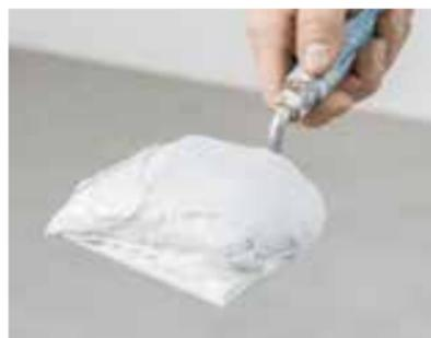
Prélever la masse à jointoyer prête à l'emploi directement depuis le bidon et la mettre en œuvre.
