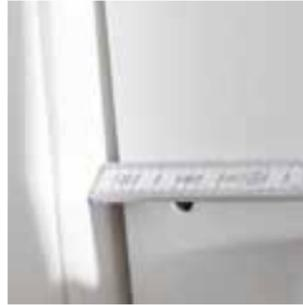
Éliminer les éventuelles bavures laissées par la spatule une fois que la masse à jointoyer a durci. Si l'interstice pour le joint fait plus de 5 mm, il faut spatuler une bande d'armature Rigips®.
