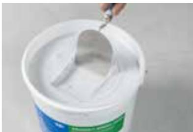
Le spatulage système Rigips® ProMix Spray Joint est une masse à jointoyer de finition pâteuse. Il est directement prêt à l'emploi et utilisable.
