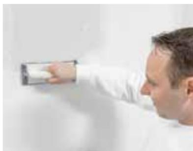
Contrôler visuellement la qualité de l'exécution du remplissage des joints, ainsi que l'élimination des éventuelles bavures laissées par la spatule.
