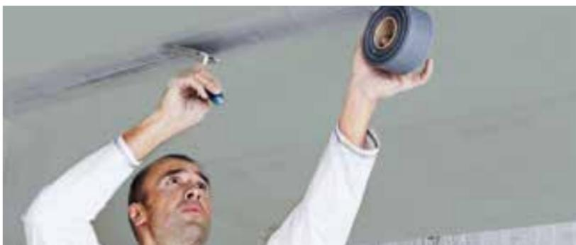
Poser la bande d'armature de treillis en fibre de verre Rigips® Aquaroc FibaTape dans la masse à jointoyer Rigips® Aquaroc ProMix Finish. Une fois que la masse à jointoyer a suffisamment séché, respatuler.
