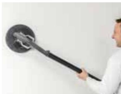
Si nécessaire, poncer la surface à la machine avec un papier abrasif 120, ou à la main avec un papier abrasif 220.
