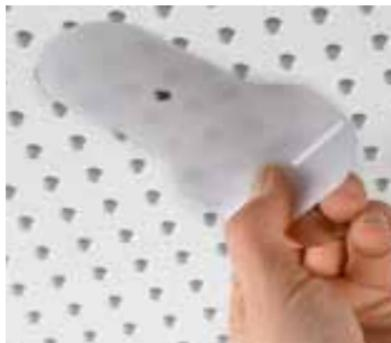
Lisser les têtes de vis au moyen d'un gabarit pour têtes de vis Rigips®.
