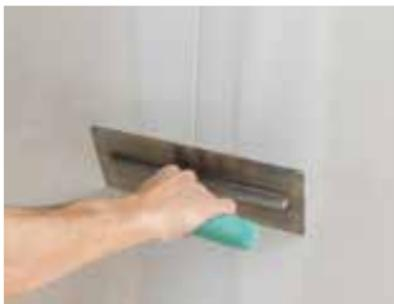
Après séchage complet, appliquer environ 1 mm d'épaisseur de masse à jointoyer.
