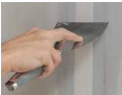
Enfoncer la bande d'armature papier Rigips® dans la couche de masse à jointoyer préalablement appliquée, en veillant à ce que cela ne fasse pas de bulles.
