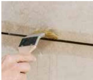
Après la pose, l'écart entre les plaques Rigidur® H est de 5 à 7 mm. Important: Dépoussiérer les bords des plaques. Ils doivent être humidifiés ou apprêtés avec la barrière neutre Rigips® Rikombi pour que l'eau ne se retire pas trop rapidement du système de masse à jointoyer Rigips®, qui sécherait alors trop rapidement.
