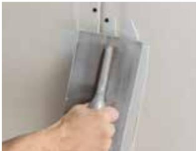
Comblers les joints longitudinaux perpendiculairement au bord des plaques avec le spatulage système Rigips® Promix.
