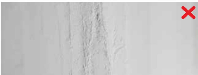
**!** Si le joint est spatulé avec le dos de la truelle une fois que le produit a pris, cela endommage la bande d'armature et le joint perd sa solidité.
