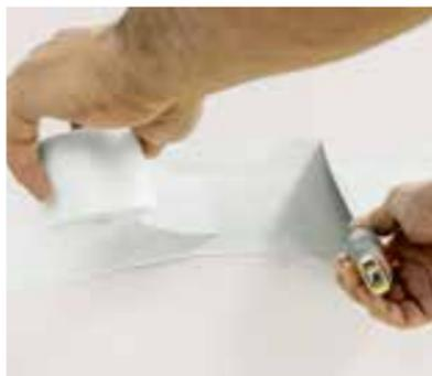
Placer la bande d'armature en fibres de verre Rigips® sur la masse à jointoyer. La bande d'armature en fibres de verre ne doit pas être recouverte à l'endroit du raccord entre les joints longitudinaux et transversaux.
