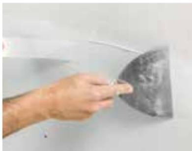
Enrober la bande d'armature Rigips® sans jointoiement ultérieur immédiat. Recouvrir les fixations de masse à jointoyer.
