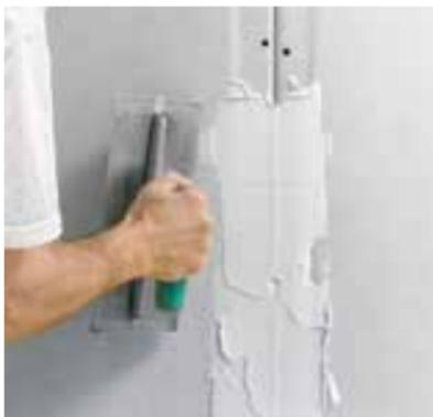
Comblent les joints longitudinaux perpendiculairement au bord Vario avec la masse à jointoyer Rigips® Vario.
