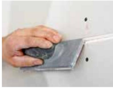
Casser le carton au niveau des transitions supérieure et inférieure entre la surface de carton et le noyau de plâtre.
