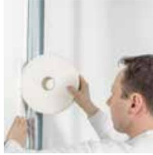
Les plaques de plâtre Rigips® doivent bien s'appuyer contre la bande d'étanchéité. S'il y a un interstice pour le joint, alors le joint doit être biseauté et rempli de spatulage système.
