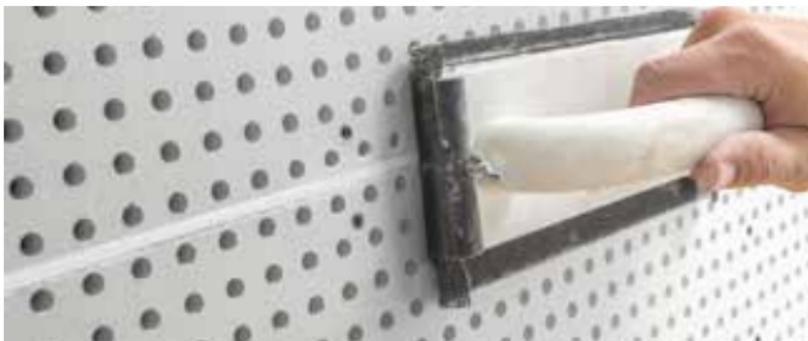
Après environ 3 heures, finaliser en ponçant la zone des joints et les têtes de vis lissées, et préparer pour le traitement ultérieur de la surface.
