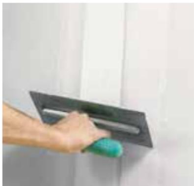
Le spatulage de finition avec la masse à jointoyer Rigips® peut être appliqué une fois que le produit utilisé pour le remplissage des joints a pris.
