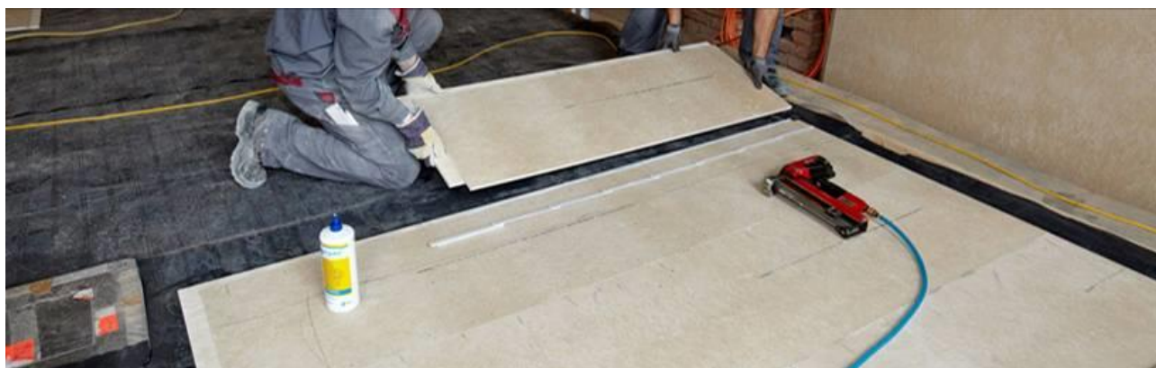
Illustration 7: pose des éléments pour chape Rigidur®
