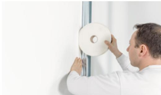
Les plaques de plâtre Rigips® doivent bien s'appuyer contre la bande d'étanchéité. S'il y a un interstice pour le joint, alors le joint doit être biseauté et rempli de spatulage système.
