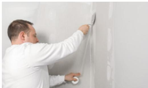
Si un bout de bande d'étanchéité Rigips® Fix dépasse, il faut le couper à fleur de surface.
