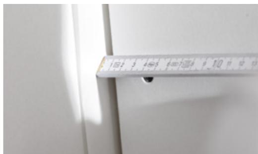
Éliminer les éventuelles bavures laissées par la spatule une fois que la masse à jointoyer a durci. Si l'interstice pour le joint fait plus de 5 mm, il faut spatuler une bande d'armature Rigips®.
