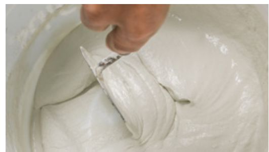
Laisser saturer environ 3 minutes, puis remuer la pâte pour la rendre bien homogène.
