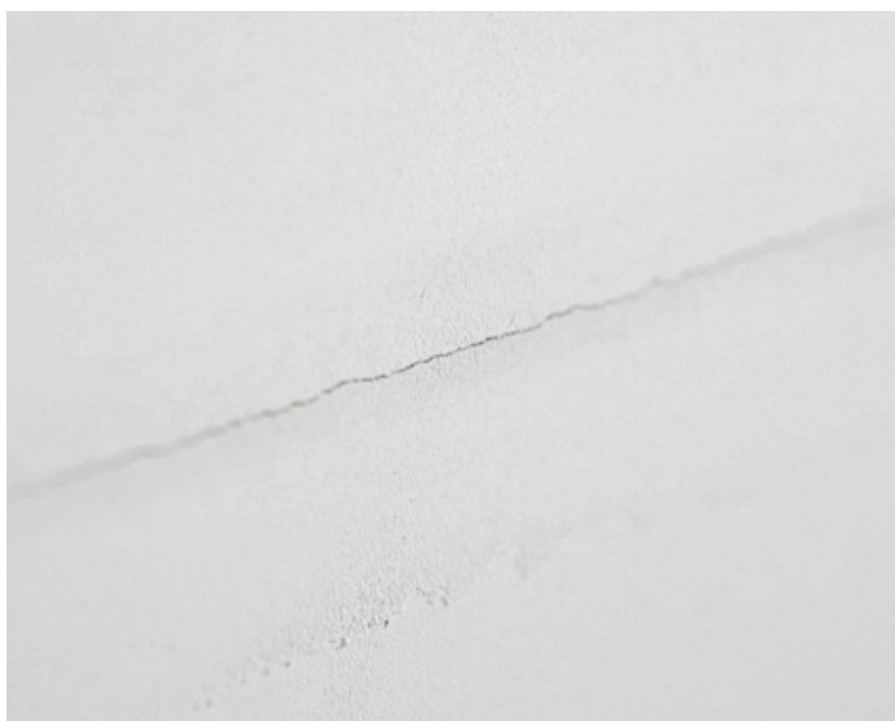
Des fissures discontinues apparaissent souvent dans le joint suite aux processus décrits ci-dessus.
