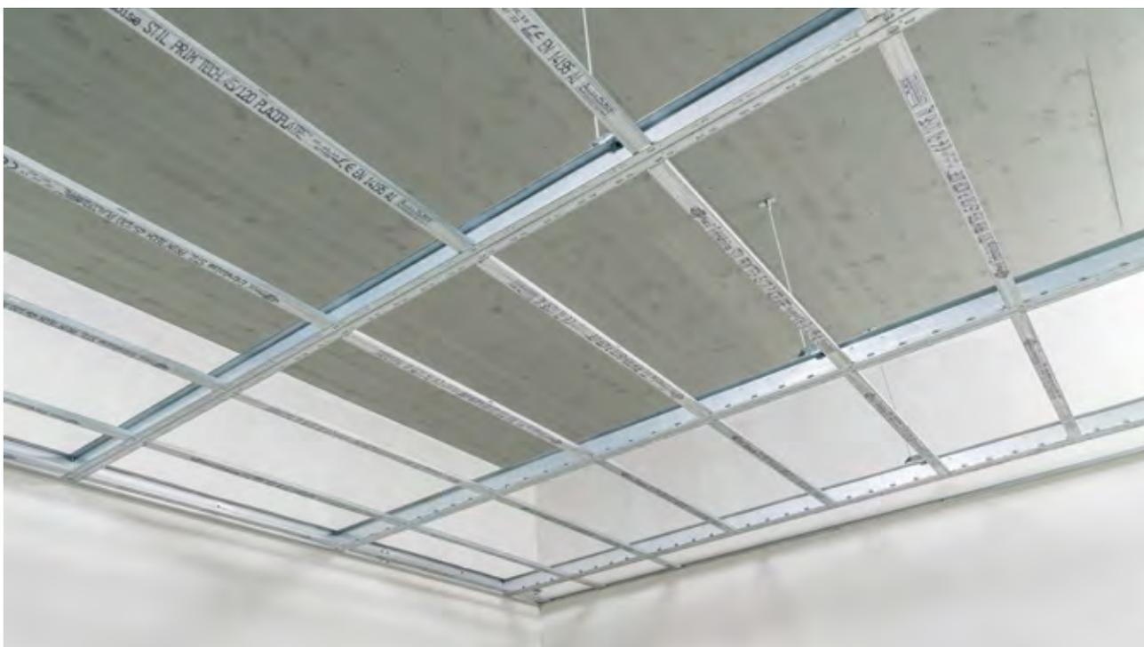
Le nouveau système pour plafonds à grande portée de Rigips est constitué d'une double structure porteuse. La sous-construction est réalisée avec des profilés Stil Prim® Tech 400/600. La structure porteuse peut être réalisée, indépendamment de la portée, de deux manières différentes:
