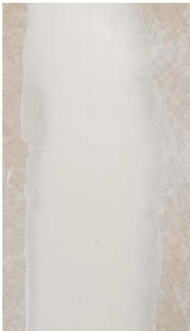
Fugenbild mit Rigidur® SK-Kanten in Klebefugentechnik, SK-Kanten auf Stoss stumpf verlegt und mit Rigidur® Fugenkleber verklebt. Überspachtelung der Fuge und Befestigungsmittel mit Rigips® Vario Fugenspachtel.
