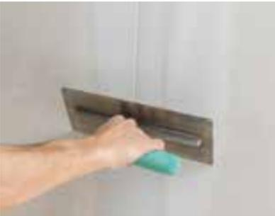
Nach vollständiger Trocknung, wird eine ca. 1 mm dicke Spachtelschicht aufgetragen.
