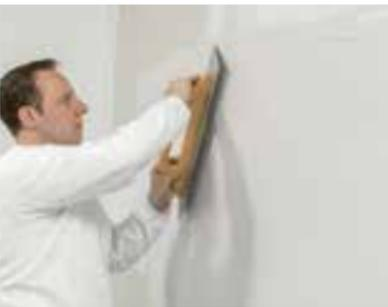
Die frisch aufgetragene Spachtelmasse wird mit einem Flächenspachtel glatt abgezogen und muss vollständig getrocknet werden lassen.
