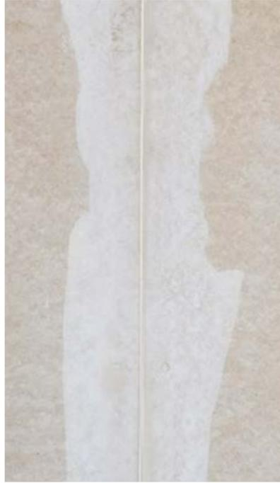
Fugenbild mit Rigidur® SK-Kanten in Spachtelfugentechnik mit 5 mm Fugenspalt und Verarbeitung mit Rigips® Vario Fugenspachtel.
