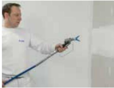
Die Fertigspachtelmasse wird in gleichmässigen Bewegungen vollflächig auf die Wandoberfläche aufgebracht. Für die Qualitätsstufe 4 (Q4) ist ein zweimaliger Auftrag erforderlich.
