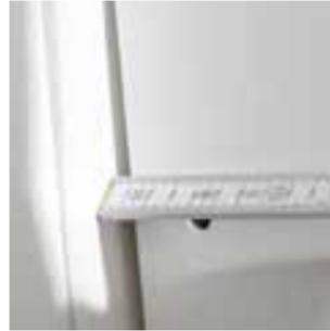
Nach dem Aushärten des Fugen-spachtels werden eventuelle Spachtelgrate entfernt. Bei einem Fugenabstand grösser 5 mm ist ein Rigips® Bewehrungsstreifen inzuspachteln.
