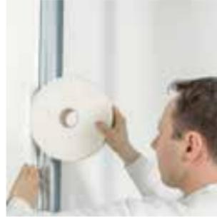
Die Rigips® Gipsplatten werden satt an den Trennstreifen gestossen. Bei einem Fugenabstand muss die Fuge angefasst und mit Systemspachtel gefüllt werden.
