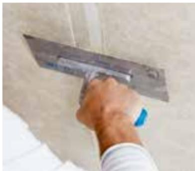
Die Rigidur® H Platten werden an den abgeflachten Kanten stumpf gegeneinander gestossen. Der Rigips® Vario Fugenspachtel wird aufgebracht und flächenbündig abgezogen.
