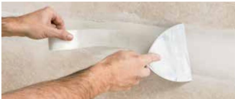
Zur Fugenbewehrung kann der Rigips® Bewehrungsstreifen eingebettet werden. Dieser wird ohne zusätzlichen Materialauftrag abgezogen.
