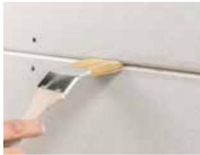
Die Querkanten müssen vorgelässt oder mit Rigips® Rikombi Sperre neutral grundiert werden, damit dem Rigips® Systemfugenfüller das Wasser nicht zu schnell entzogen wird und nicht zu schnell austrocknet.
