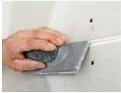
Der Karton wird am oberen und unteren Übergang der Kartonoberfläche zum Gipskern gebrochen.
