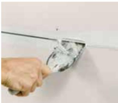
Die Fugen werden mit Rigips® Vario Fugenspachtel ausgefüllt. Dabei ist auf eine ausreichende Flankenhaftung an den Plattenkanten zu achten.
