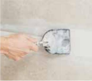
Ca. 1mm dicke Spachtelschicht auftragen.
