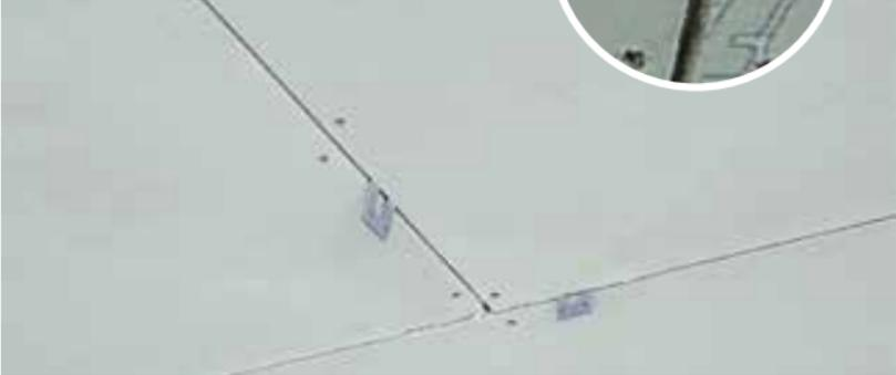
Bei der Deckenmontage werden die Rigips® Aquaroc Platten im Verbund mit 5 mm Breite verlegt.
