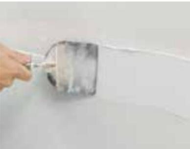
Ca. 1mm dicke Spachtelschicht auftragen.
