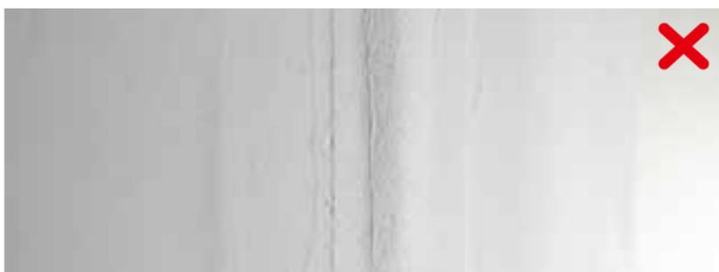
**!** Überzieht man den Rigips® Glasvlies-Bewehrungsstreifen nach dem Einlegen sofort mit weiterem Spachtelmaterial entsteht ein «Durchwalg»-Effekt, d.h., der Glasvlies-Bewehrungsstreifen fällt in der Mitte der Fuge nach aussen und steht nach vorne ab.
