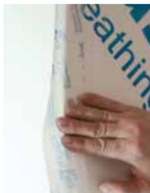
Das Rigips® Glasroc X Fugenband ist überlappend zu verkleben. Auch die Innenecke der Brüstungsplatte zum Fensterrahmen hin wird überklebt um ein Eindringen von Feuchtigkeit zum Holzrahmen und/oder weiteren Anschlussstellen hin zu verhindern. Die Verklebung muss sorgfältig und kraftschlüssig angebracht werden, damit das Rigips® Glasroc X Fugenband für die garantierten drei Monate einen guten Wetterschutz bietet.
