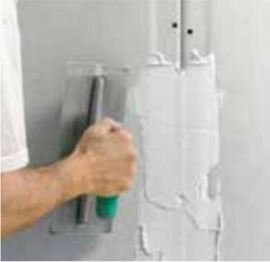
Die Längsfugen werden quer zur Vario Kante mit Rigips® Vario Fugenspachtel ausgedrückt.
