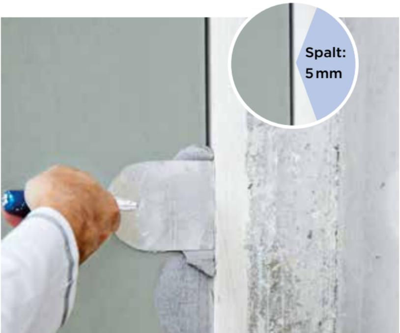
Alle Anschlüsse an angrenzende Bauteile müssen mit einem Abstand der Platten von 5 mm erfolgen. Die Fugen sind mit der Systemspachtelmasse Rigips® Aquaroc ProMix Finish zu verfüllen. Nach dem Aushärten der Spachtelmasse wird der Überstand des Trennstreifens flächenbündig abgetrennt.
