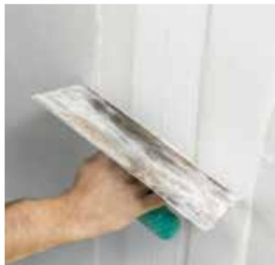
Die Ebenheit muss geprüft und eventuelle Spachtelgrate müssen mit dem Kellenrücken abgestossen oder abgeschliffen werden.
