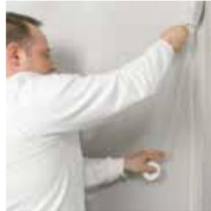
Der Überstand des Rigips® Fix Trennstreifens wird flächenbündig abgetrennt.
