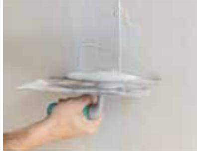
Danach erfolgt das Abziehen der vorgefüllten Fugen. Fugenfüller trocknen lassen.
