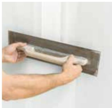
Die Nachspachtelung wird mit nahezu anliegender Kelle in einem geraden und schnellen Zug geglättet. Somit ist die Qualitätsstufe 2 (Q2) erreicht.
