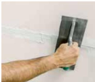
Danach erfolgt das Abziehen der vorgefüllten Fugen. Fugenfüller abbinden lassen.
