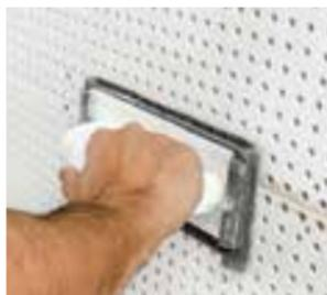
Den Fugenbereich mittels Schwamm in Fugenrichtung leicht anfeuchten.
