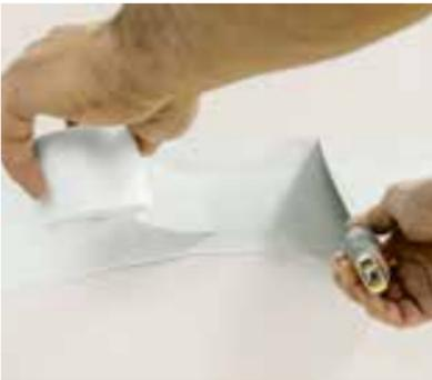
Der Rigips® Glasvlies-Bewehrungsstreifen wird auf den Fugenspachtel aufgelegt. Im Anschlussbereich der Längs- und Querfugen darf es zu keiner Überlappung der Glasvlies-Bewehrungsstreifen kommen.
