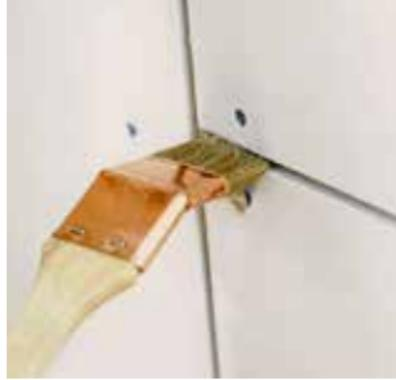
Die Plattenkanten müssen entstaubt und vorgenässt respektive mit Rigips® Rikombi Sperre neutral grundiert werden.
