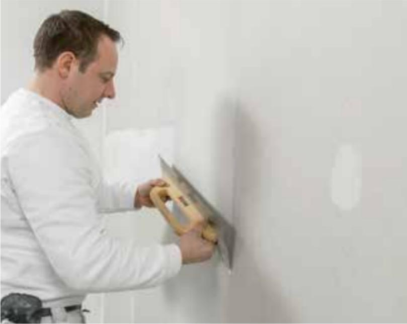
Der Finish wird mithilfe eines Glättspachtels auf den Untergrund aufgetragen.
