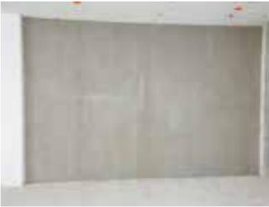
Durch das scharfe Abziehen der gesamten Oberfläche in einem nächsten Arbeitsgang wird die Qualitätsstufe 3 (Q3) erreicht.
