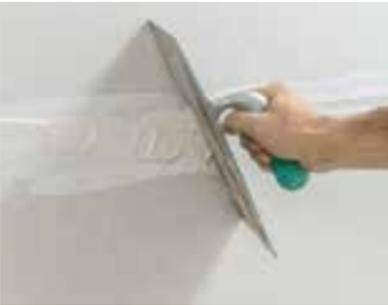
Die Querfugen werden mit dem Rigips® Fugenfüller ausgedrückt.
