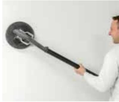
Ob ein Nachschleifen (manuell oder maschinell) der durchgetrockneten Spachtelmasse erforderlich ist, hängt von der vereinbarten Oberflächenqualität bzw. vorgegebenen Oberflächengüte ab.
