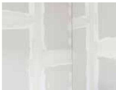
Nach dem Abbinden des Fugenfüllers wird die Fuge nochmals ausgespachtelt.
