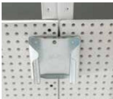
Ist die Plattenmontage abgeschlossen und sind die einzelnen Platten mit Hilfe der zum Lochbild gehörenden Montagehilfen ausgerichtet, werden sie – nach optischer Kontrolle – über die Lochreihen hinweg verschraubt (gerade und diagonal).
