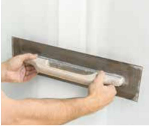
Nach der planebenen Nachspachtelung der Fugen ist die Oberfläche für die nachfolgende Bearbeitung vorbereitet.
