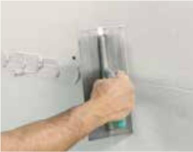
Querfugen werden ausgedrückt. Anschliessend trocknen lassen.
