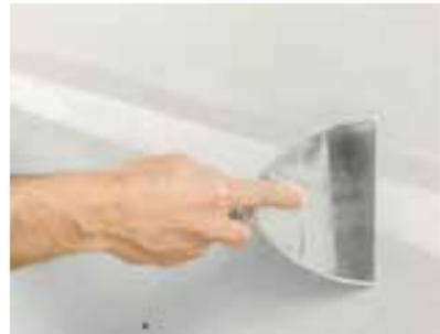
Die Einbettung des Rigips® Papier-Bewehrungsstreifens erfolgt mit zusätzlichem Materialauftrag.
