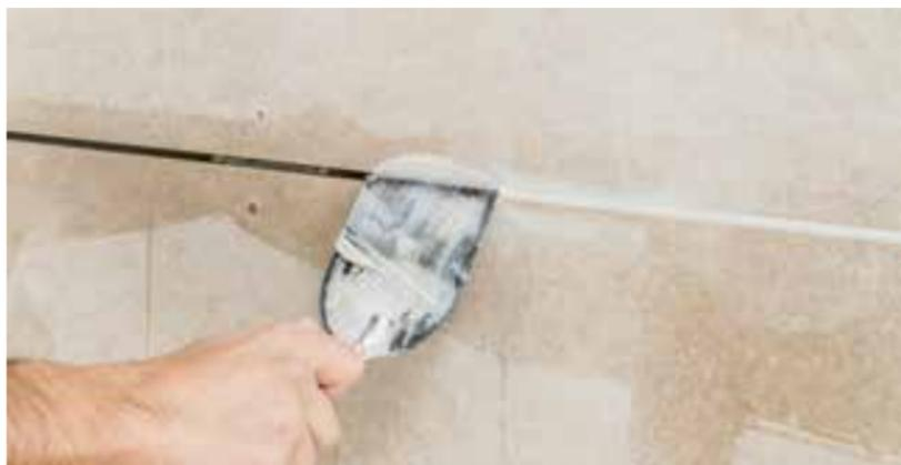
Die Fuge wird mit Rigips® Vario Fugenspachtel ausgefüllt. Anschliessend trocknen lassen.
