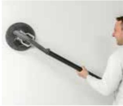
Ein eventuelles Nachschleifen erfolgt nach der kompletten Austrocknung der Nachspachtelung. Dies kann sowohl manuell als auch maschinell erfolgen.
