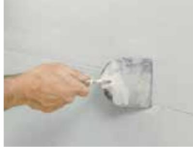
Ca. 1mm dicke Spachtelschicht auftragen
