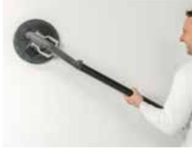
Ein eventuelles Nachschleifen erfolgt nach der kompletten Austrocknung der Nachspachtelung. Dies kann sowohl manuell als auch maschinell erfolgen.
