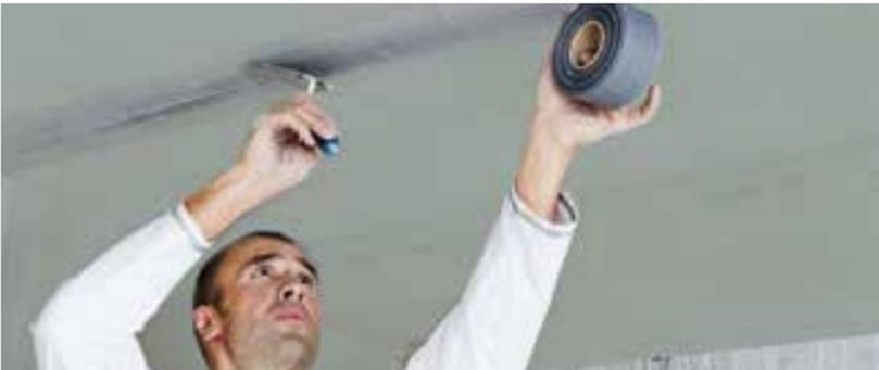
Der Glasgitter-Bewehrungsstreifen Rigips® Aquaroc FibaTape wird in die Rigips® Aquaroc ProMix Finish Spachtelmasse eingebettet. Nach ausreichender Trocknung kann mit der Nachspachtelung begonnen werden.
