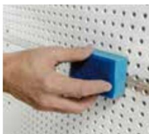
Der Primeline Strip wird mit der gummierten Seite mittig auf den angefeuchteten Plattenstoss fixiert und mit Druck des Daumens angedrückt bis beide Seiten des Primeline Strip einen kompletten Kontakt zur Lochplatte aufweisen.
