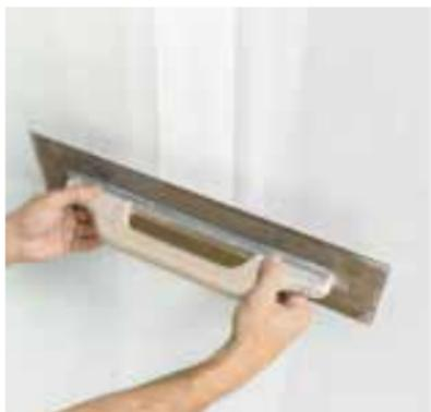
Das Spachtelmaterial wird in langen Zügen auf der Plattenoberfläche bis zum Nullpunkt ausgezogen.
