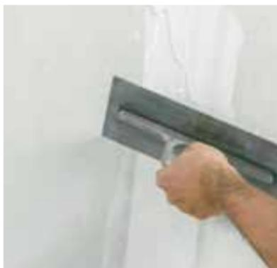
Die Längsfugen werden quer zur abgeflachten Kante mit dem Rigips® Systemfugenfüller ausgedrückt und scharf abgezogen.
