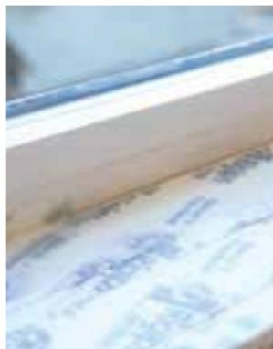
Ebenfalls werden die Übergänge von der Brüstungsplatte zur Laibung hin mit dem Rigips® Glasroc X Fugenband überlappend verklebt, um auch hier einen ausreichenden Schutz vor Feuchtigkeit zu gewährleisten. Überlappungen sind so immer auszuführen, dass ablaufendes Wasser das darunterliegende Fugenband nicht unterlaufen kann!
