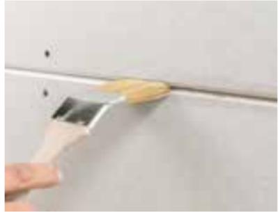
Die Entfernung des Gipsstaubs sorgt für eine gute Haftung zwischen Spachtelmasse und Plattenquerkante.
