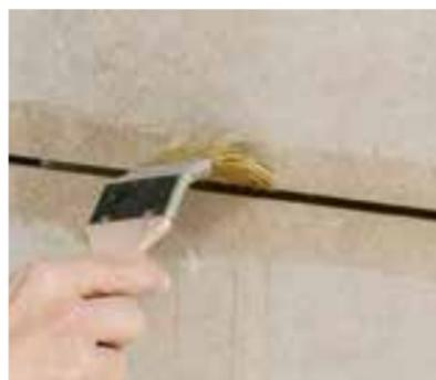
Der Abstand der montierten Rigidur® H Platten beträgt ca. 5 bis 7 mm. Wichtig: Die Plattenkanten werden entstaubt und müssen vorgehässt oder mit Rigips® Rikombi Sperre neutral grundiert werden, damit dem Rigips® Systemfugenfüller das Wasser nicht zu schnell entzogen wird und nicht zu schnell austrocknet.
