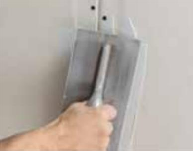
Die Längsfugen werden quer zur Plattenkante mit dem Rigips® ProMix Systemspachtel ausgedrückt.
