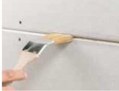
Die Querkanten müssen vorgelassen oder mit Rigips® Rikombi Sperre neutral grundiert werden, damit dem Rigips® Systemfugenfüller das Wasser nicht zu schnell entzogen wird und nicht zu schnell austrocknet.
