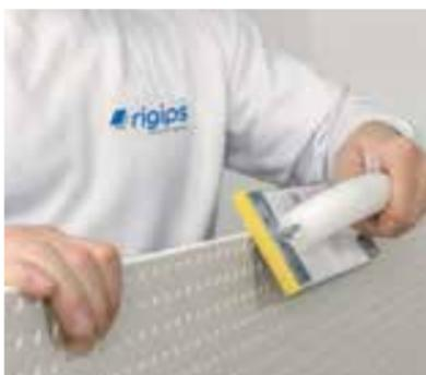
Die Rigiton® Ambiance Plattenkanten werden mit einem Handschleifer leicht gebrochen und danach mit der Rigips® Rikombi Sperre neutral an allen Seiten grundiert.
