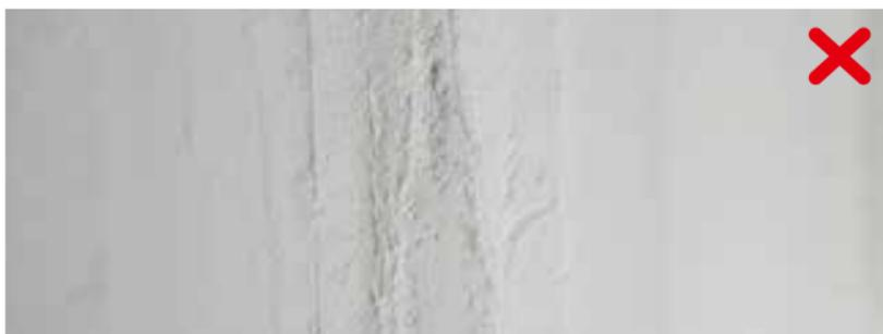
**!** Zieht man dann nach dem Abbinden des Materials die Fuge mit dem Rücken der Glättkelle ab, zerstört man den Bewehrungsstreifen und die Fugenfestigkeit ist nicht mehr gegeben.
