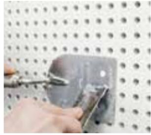
Nach Austrocknung der Schraubenkopfverspachtelung wird die Abrollstruktur der Lammfellrolle auf der Fugenoberfläche mit Schleifgitter in Fugenrichtung leicht egalisiert. Sie wird nicht abgeschliffen.
