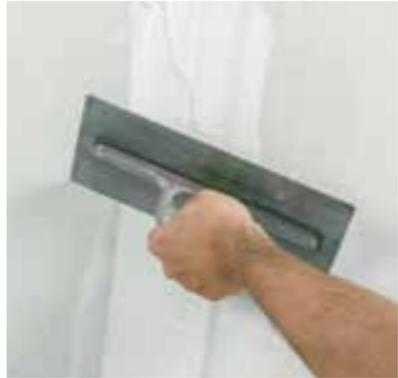
Danach erfolgt das Abziehen der vorgefüllten Fugen.
