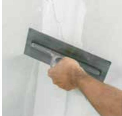
Danach erfolgt das Abziehen der vorgefüllten Fugen.
