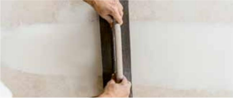
Die komplett ausgefüllte Spachtelfuge (von oben) mit planebenem Ergebnis.
