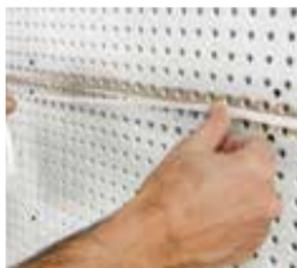
Den Flüssigkleber mit der Lammfellrolle aufnehmen und über das Abstreifgitter nach unten abrollen. Dann – nach Aufbringen des Primeline Strips Fugenbereich – mit Flüssigkleber satt überdecken. Lammfellrolle nur mit leichtem Druck über die Deckenfläche abrollen. Die Abrollstruktur der Lammfellrolle muss gut sichtbar sein.
