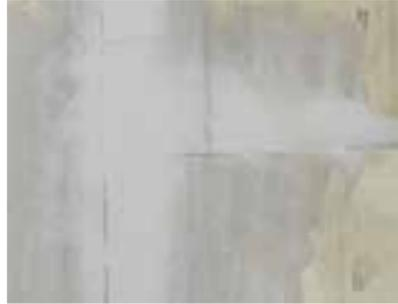
Danach folgt die Verspachtelung der Fugenbereiche sowie das scharfe Abziehen der Oberfläche (Q2).
