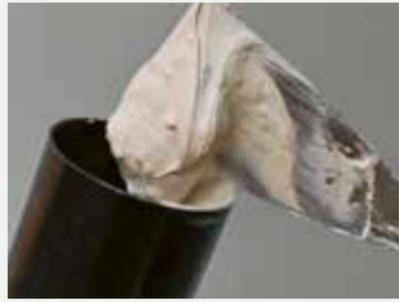
2. Die angerührte Rigips® Vario Fugenspachtelmasse wird zügig in die leicht schräg gestellte Kartusche eingefüllt.
