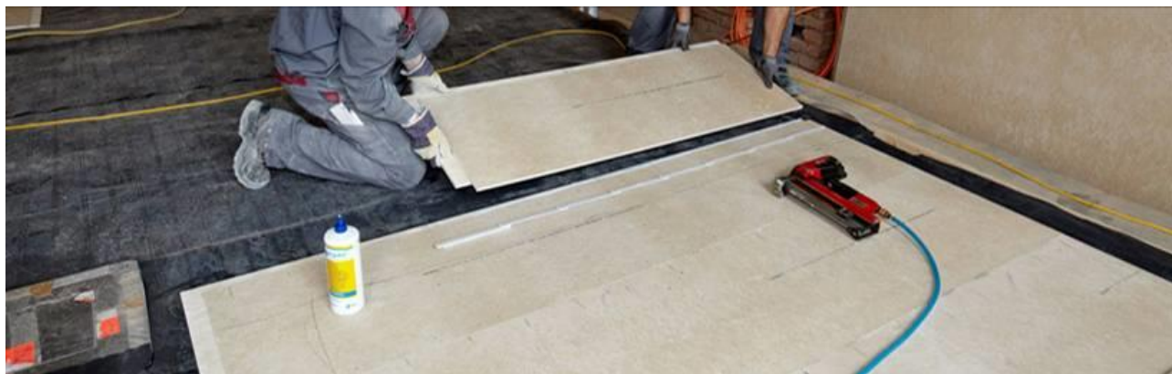
Abbildung 7: Verlegung von Rigidur® Estrichelementen
