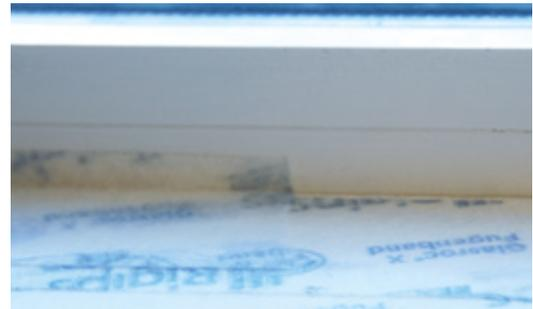
Überlappungen sind so immer auszuführen, dass ablaufendes Wasser das darunterliegende Fugenband nicht unterlaufen kann!
