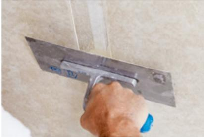
Die Rigidur® H Platten werden an den abgeflachten Kanten stumpf gegeneinander gestossen. Der Rigips® Vario Fugenspachtel wird aufgebracht und flächenebündig abgezogen.
