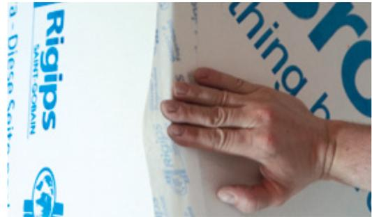
Das Rigips® Glasroc X Fugenband ist überlappend zu verkleben. Auch die Innenecke der Brüstungsplatte zum Fensterrahmen hin wird überklebt um ein Eindringen von Feuchtigkeit zum Holzrahmen und/oder weiteren Anschlussteilen hin zu verhindern. Die Verklebung muss sorgfältig und kraftschlüssig angebracht werden, damit das Rigips® Glasroc X Fugenband für die garantierten drei Monate einen guten Wetterschutz bietet.
