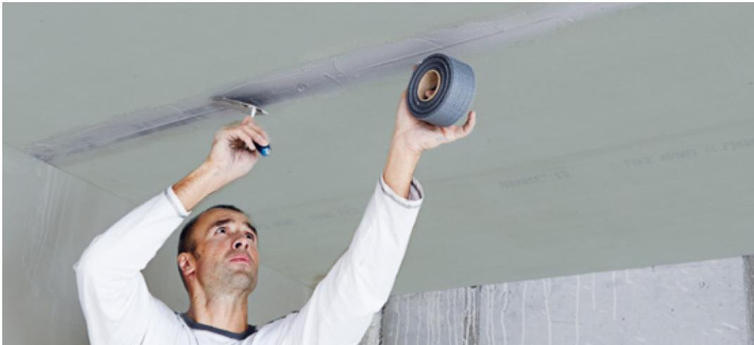
Der Glasfiter-Bewehrungsstreifen Rigips® Aquaroc FibaTape wird in die Rigips® Aquaroc ProMix Finish Spachtelmasse eingebettet. Nach ausreichender Trocknung kann mit der Nachspachtelung begonnen werden.
