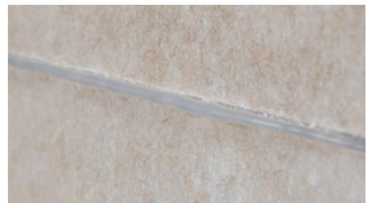
Die Nachspachtelung der Plattenstöße bei der Klebefugentechnik erfolgt mit Rigips® Vario Fugenspachtel **ohne** Bewehrungsstreifen, wenn die Armierung durch die **spätere** Beschichtung gewährleistet ist; zum Beispiel bei der Applizierung von einer Glasfasertapete.
