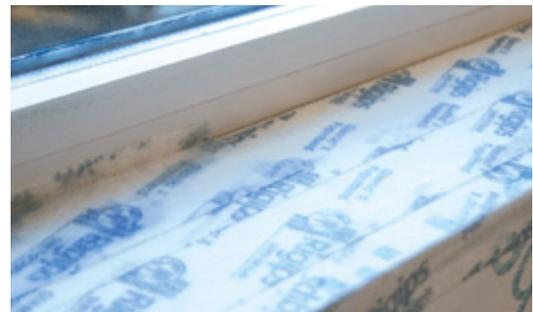
Ebenfalls werden die Übergänge von der Brüstungsplatte zur Laibung hin mit dem Rigips® Glasroc X Fugenband überlappend verklebt, um auch hier einen ausreichenden Schutz vor Feuchtigkeit zu gewährleisten.
