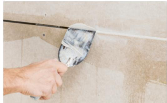
Der Abstand der montierten Rigidur® H Platten beträgt ca. 5 bis 7 mm. **Wichtig:** Die Plattenkanten werden entstaubt und müssen vorgehässt oder mit Rigips® Rikombi Sperre neutral grundiert werden, damit dem Rigips® Systemfugenfüller das Wasser nicht zu schnell entzogen wird und nicht zu schnell austrocknet.
