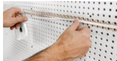
Den Flüssigkleber mit der Lammfellrolle aufnehmen und über das Abstreifgitter nach unten abrollen. Dann – nach Aufbringen des Primeline Strips Fugenbereich – mit Flüssigkleber satt überdecken. Lammfellrolle nur mit leichtem Druck über die Deckenfläche abrollen. Die Abrollstruktur der Lammfellrolle muss gut sichtbar sein.
