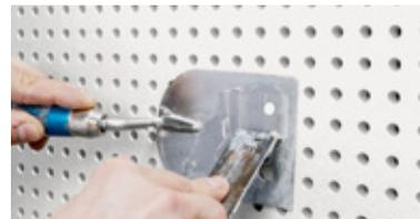
Nach Austrocknung der Schraubenkopfverspachtelung wird die Abrollstruktur der Lammfellrolle auf der Fugenoberfläche mit Schleifgitter in Fugenrichtung leicht egalisiert. Sie wird nicht abgeschliffen.
