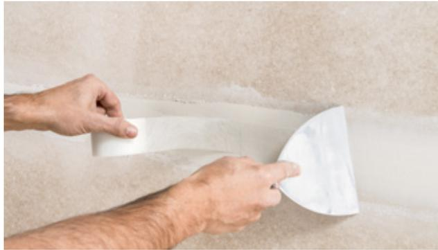
Zur Fugenbewehrung kann der Rigips® Bewehrungsstreifen eingebettet werden. Gleich danach erfolgt das Einlegen der Rigips® Papier Bewehrungsstreifen. Dieser wird ohne zusätzlichen Materialauftrag abgezogen.
