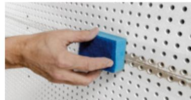
Der Primeline Strip wird mit der gummierten Seite mittig auf den angefeuchteten Plattenstoss fixiert und mit Druck des Daumens angedrückt bis beide Seiten des Primeline Strip einen kompletten Kontakt zur Lochplatte aufweisen.
