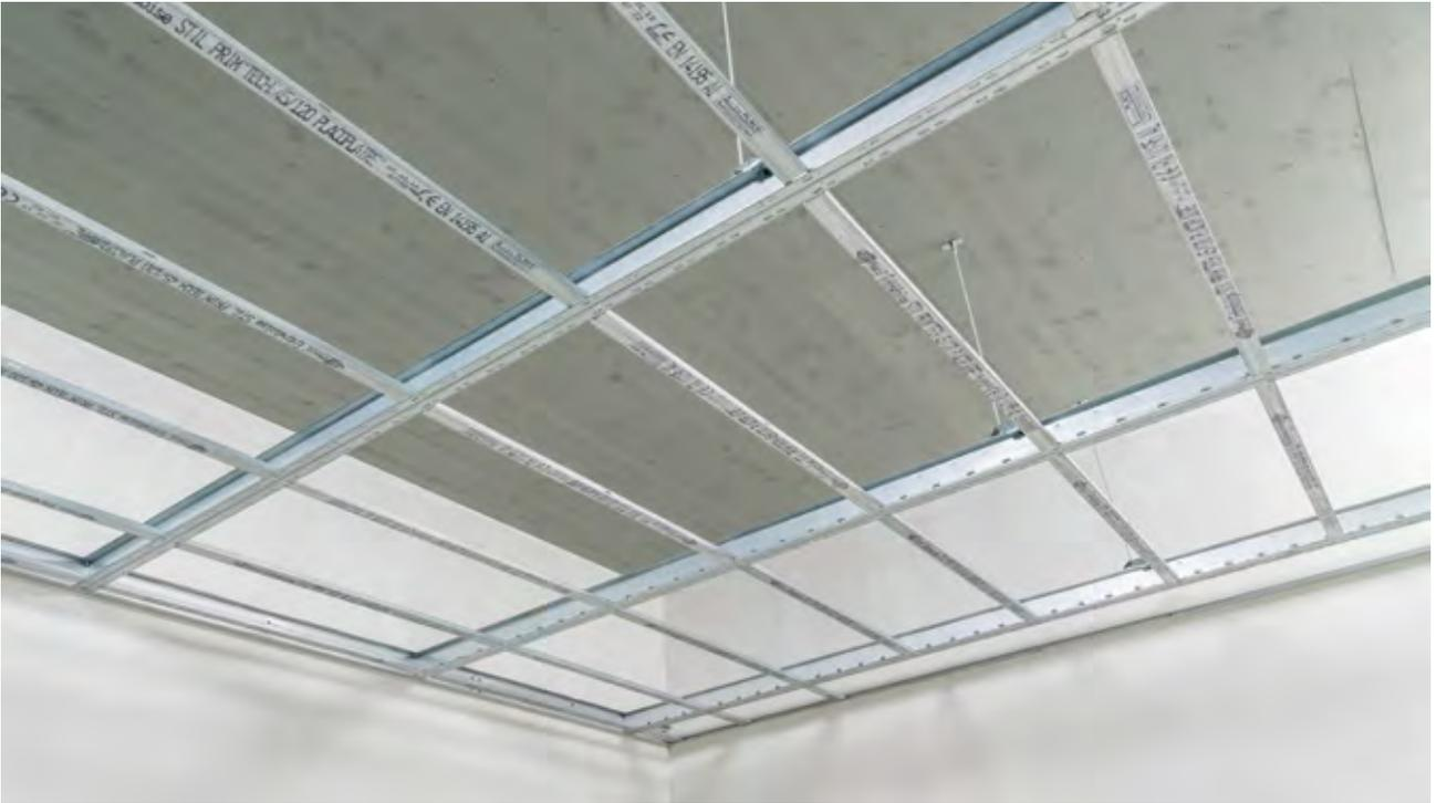
Das neue Weitspanndeckensystem von Rigips besteht aus einer doppelten Trägerkonstruktion. Die Unterkonstruktion wird mit Tragprofilen Stil Prim® Tech 400/600 erstellt. Unabhängig von der Spannweite lässt sich die Tragkonstruktion auf zwei unterschiedliche Arten erstellen:
