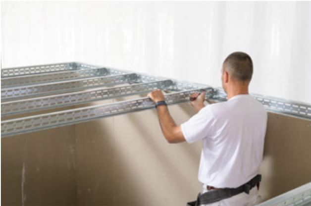
*RiBox® Deckensystem mit Weitspanträgern (UA-Profilen)*
