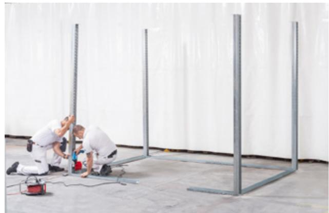
*Setzen und Befestigen aller vier Grundstützen*
