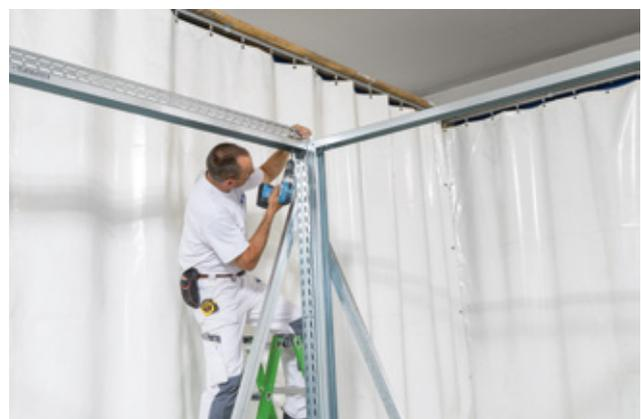
*Auflegen und Verschrauben des Rahmenprofils*
