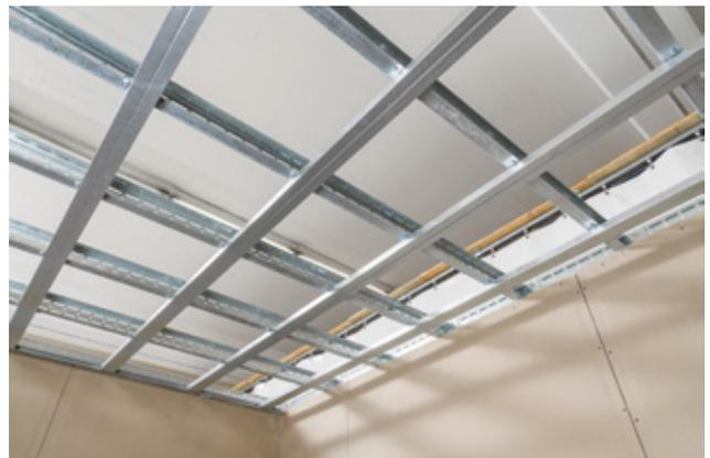
*Abgehängte Decke mit Einfachrost*
