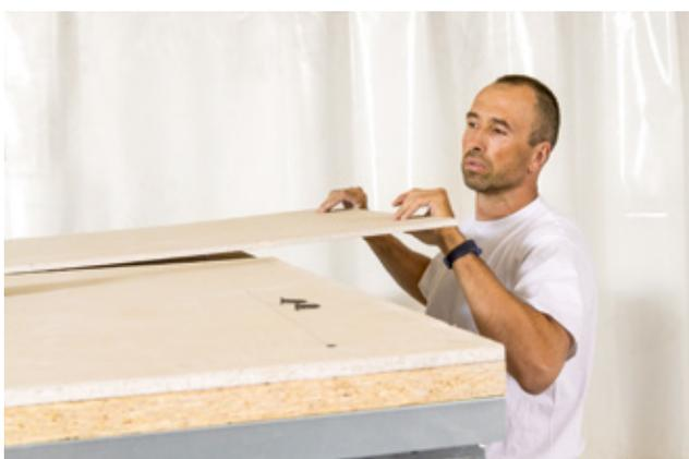
*Ausrichten und Verlegen der Brandschutzbeplankung*
